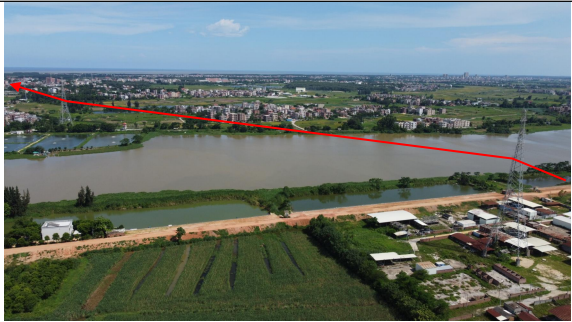
利用 220kV 岑霞（海东）输变电工程拟建的三回路铁塔线路段（跨越鉴江）
