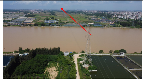
利用 220kV 岑霞（海东）输变电工程拟建的三回路铁塔线路段（跨越塘尾分洪河）
