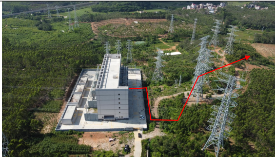
220kV 浅水站现状
