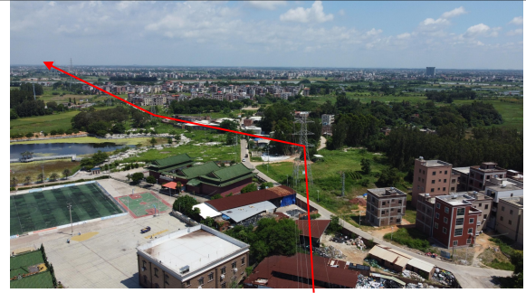
利用 220kV 岑霞（海东）输变电工程拟建的三回路铁塔线路段
