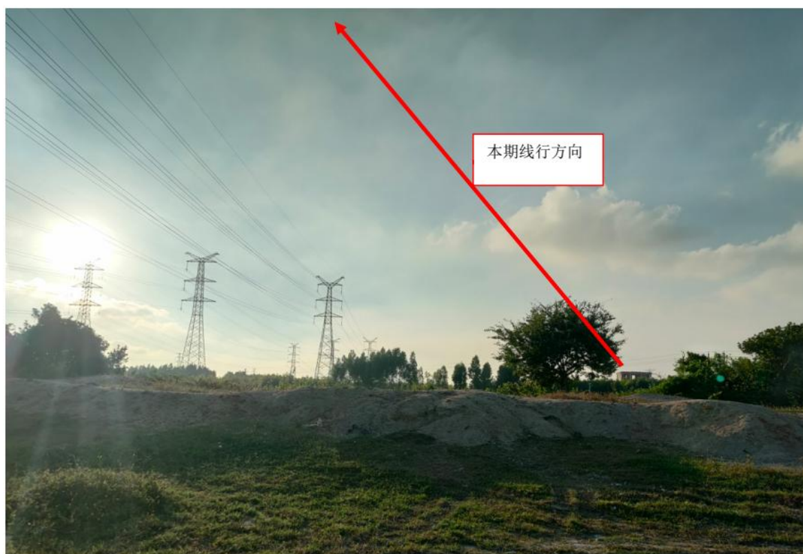
图 2-5c 220kV 拟建线路走向现场照片 2
