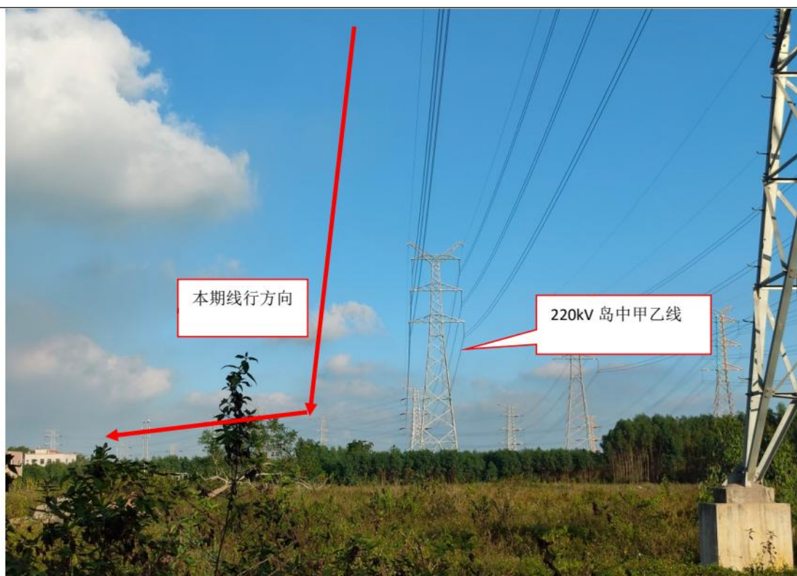
图 2-5b 220kV 拟建线路走向现场照片 1
