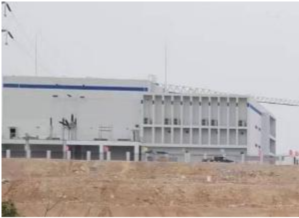
廉江核电 110kV 施工变（正在施工）
