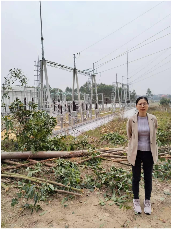
110kV 高桥变电站出线处
