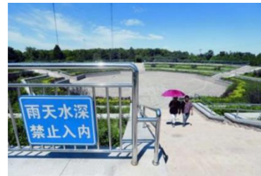
下沉式雨水调蓄广场
