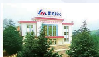
安徽雷鸣科化炸药生产车间
