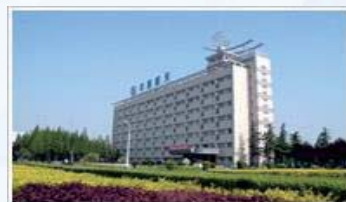
航天工业部42所襄樊固体燃料车间
