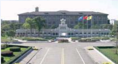
北京印钞厂检封车间(2万m 2 )
