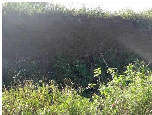
照片 8 矿区边坡表层风化残积层 (镜头向 S)
