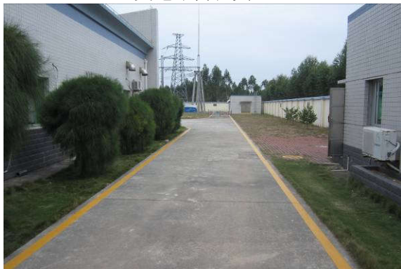
变电站道路硬化
